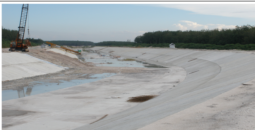
Kênh dẫn nước Phước Hoà – Dự án thủy lợi Phước Hoà (Bình Dương, Bình Phước )
